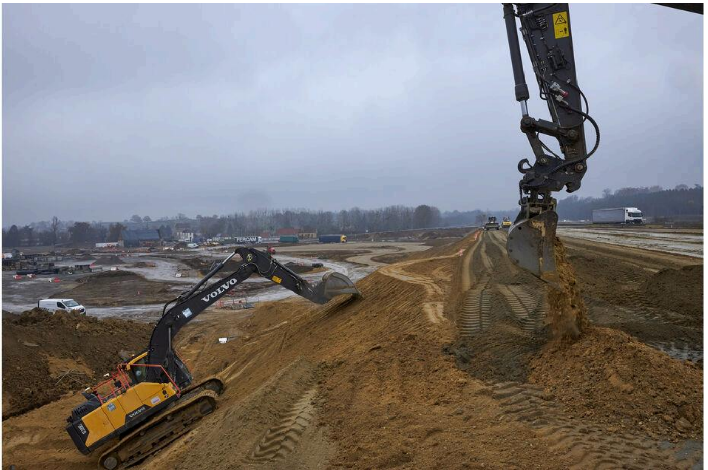
Chantier de terrassement dans l'Allier.
